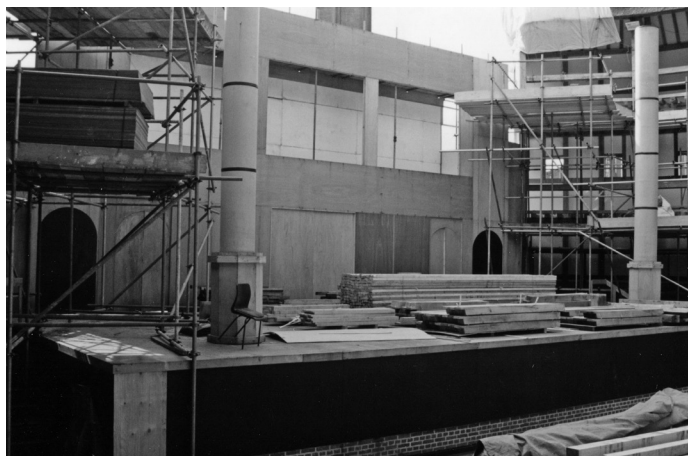
1988年から再建工事が始まったグローブ座。工事中の舞台部分には、まだ屋根がかかっていない状態。1996年春撮影。
