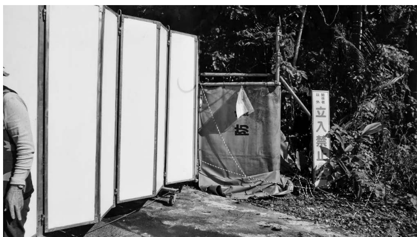
Fig1-B. 基地の工事現場。すぐうしろに Fig1-C の川があり、農業用水等に使われている。(2023年12月撮影)
