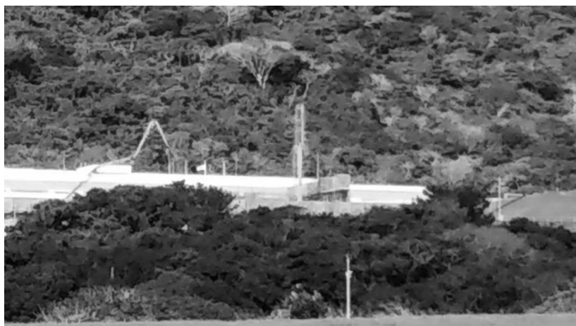
Fig1-A. 石垣に建設中の自衛隊基地。もともと景観を壊さないため、建物制限があった場所だとの説明を受けたが、それは無視されているという。米軍による共同使用が予定されている。(2023年12月撮影)
